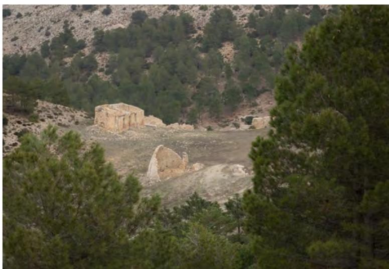
*Fotografías de Salvador Ramírez Sevilla desde una misma perspectiva hacia los pozos de Murcia. Arriba 1975, abajo 2017. Se puede apreciar como en unas pocas décadas la cúpula del pozo n° 13 prácticamente ha desaparecido, y la cubierta de la construcción n° 3 se ha caído.*
