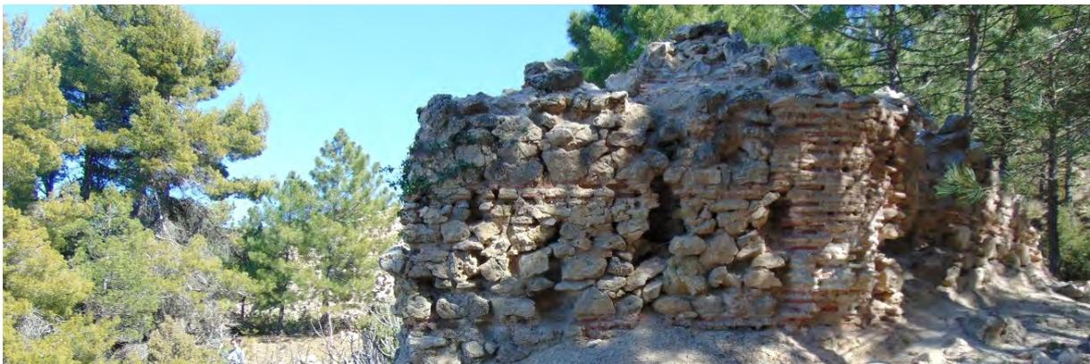
*Fábrica mixta de ladrillo y piedra en el tambor de planta hexagonal del pozo 20.*
