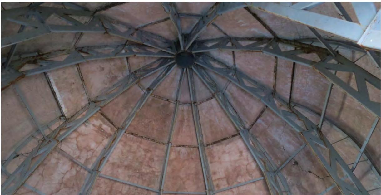
*Estructura metálica de cerchas curvas para la cúpula del pozo 6, con diversas patologías que lo hacen vulnerable ante agentes atmosféricos, especialmente ante una nevada que pudiera hacer colapsar una cúpula agrietada realizada con sistemas estructurales insolidarios como lo son los mampuestos o mortero con cerchas metálicas.*
