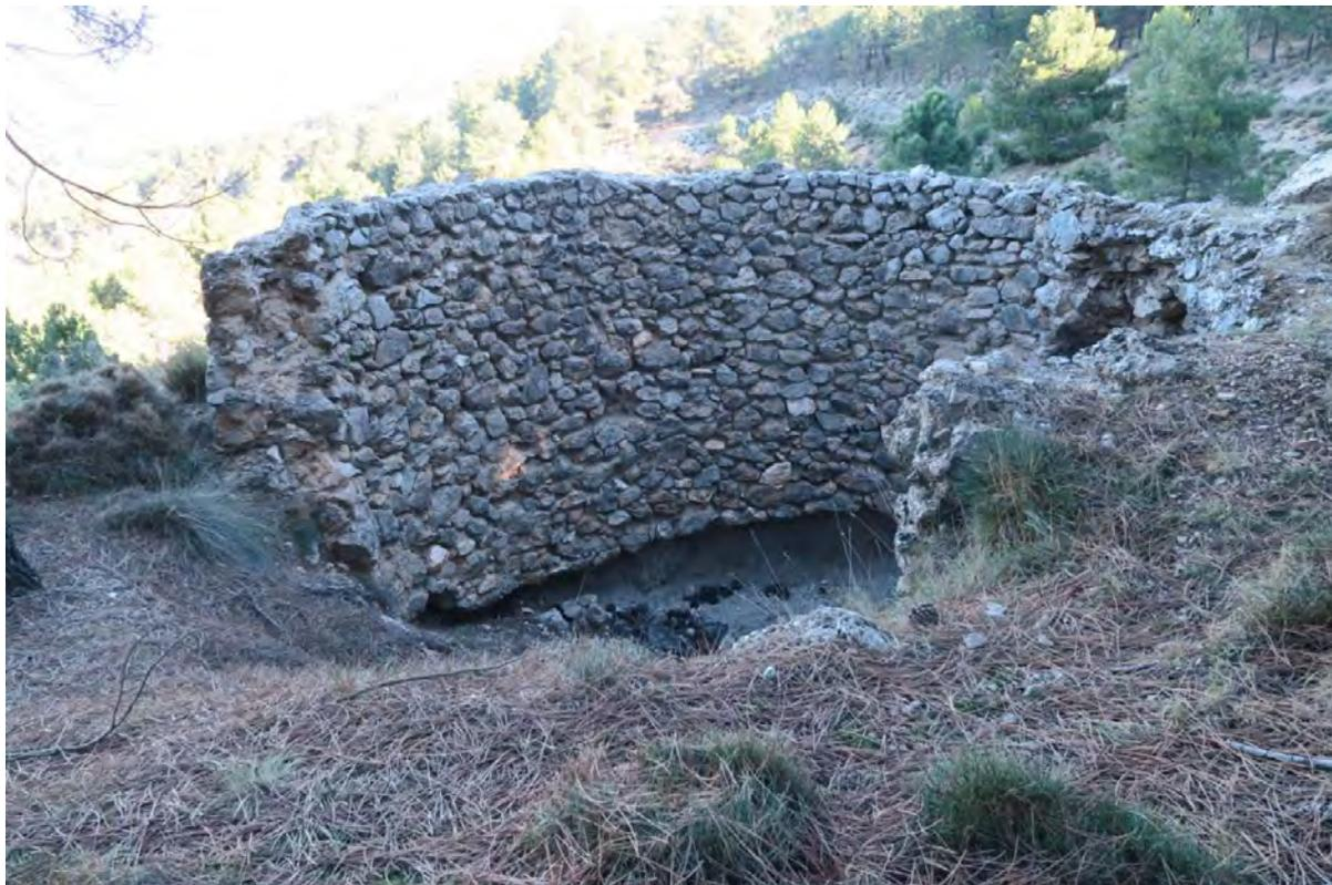
*Pozo nº 27: en esta imagen se puede apreciar como la base del muro de piedra está descalzada y el riesgo de derrumbe es elevado*
