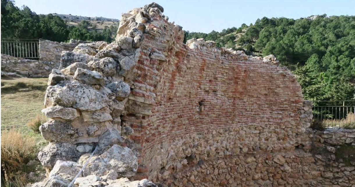
*Diferentes capas de la cúpula; interior de ladrillo y exterior de piedra del pozo 1.*
