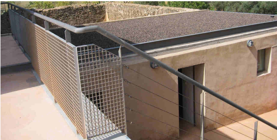
Ilustración 6. Barandilla metálica en la Mina Las Matildes.
