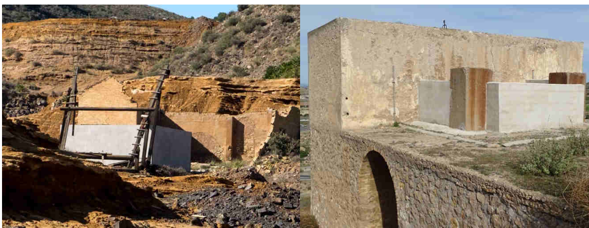
Ilustración 1. Ejemplos de brocales en bloques de hormigón y enlucidos, con fuerte impacto visual recientemente construidos en las minas San Francisco Javier (izquierda) y Nª Sª de Los Ángeles (derecha).
