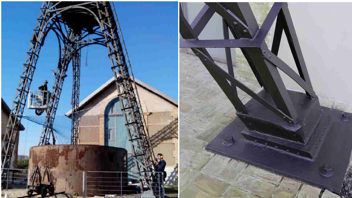
Ilustración 8. Trabajos de tratamiento y refuerzo de la estructura metálica del castillete de la Mina Las Matildes en 2015. A la derecha detalle de consolidación de los pies del castillete.
