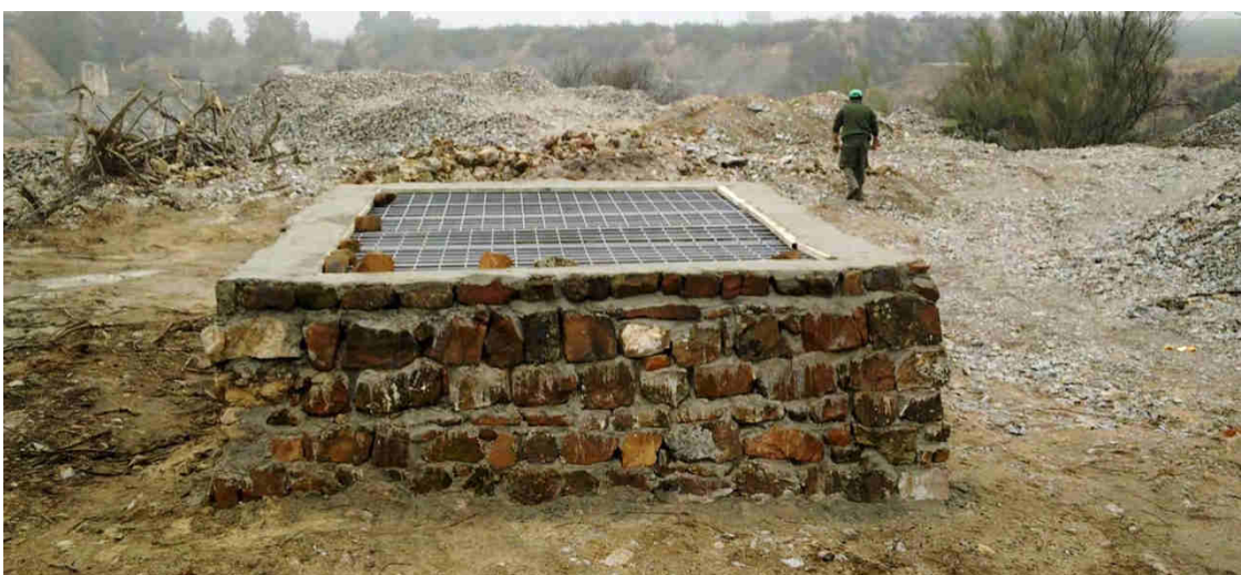
Ilustración 4. Ejemplo de reconstrucción de un brocal en el distrito minero de Linares - La Carolina. Colectivo Proyecto Arrayanes.
