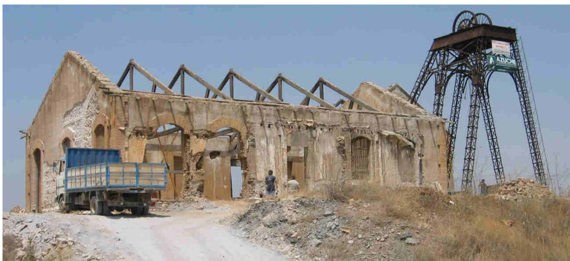
Ilustración 17. Obras de restauración integral de las casas de máquinas y el castillete de la mina Las Matildes en 2004.
