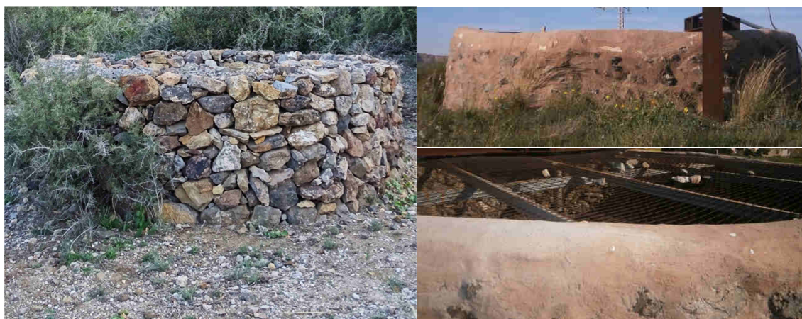
Ilustración 3. Brocal de piedra seca, en el Cabezo de San Ginés, y brocal de mampostería con rejilla superior instalada, en la mina Segunda Primavera, en el entorno de la Mina Las Matildes.
