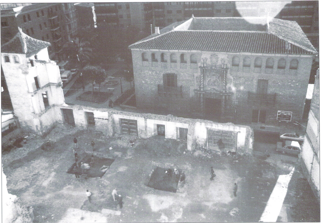
Lámina 1.- Vista aérea del solar en proceso de excavación. Al fondo el Palacio de Guevara.
