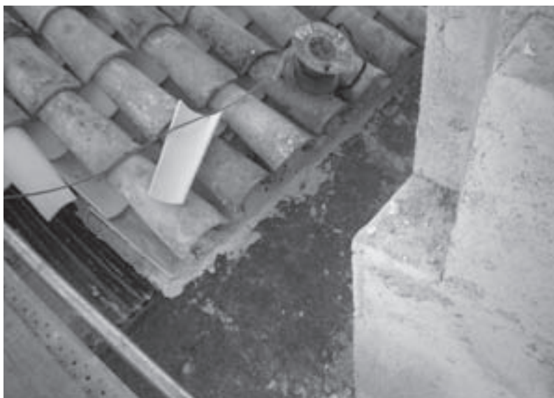
Figura 10. Fotografía tomada por noviembre de 2008, cuando se estaban interviniendo las cubiertas de la iglesia de San Roque, en la que podemos ver cómo se coloca la teja cerámica curva.
