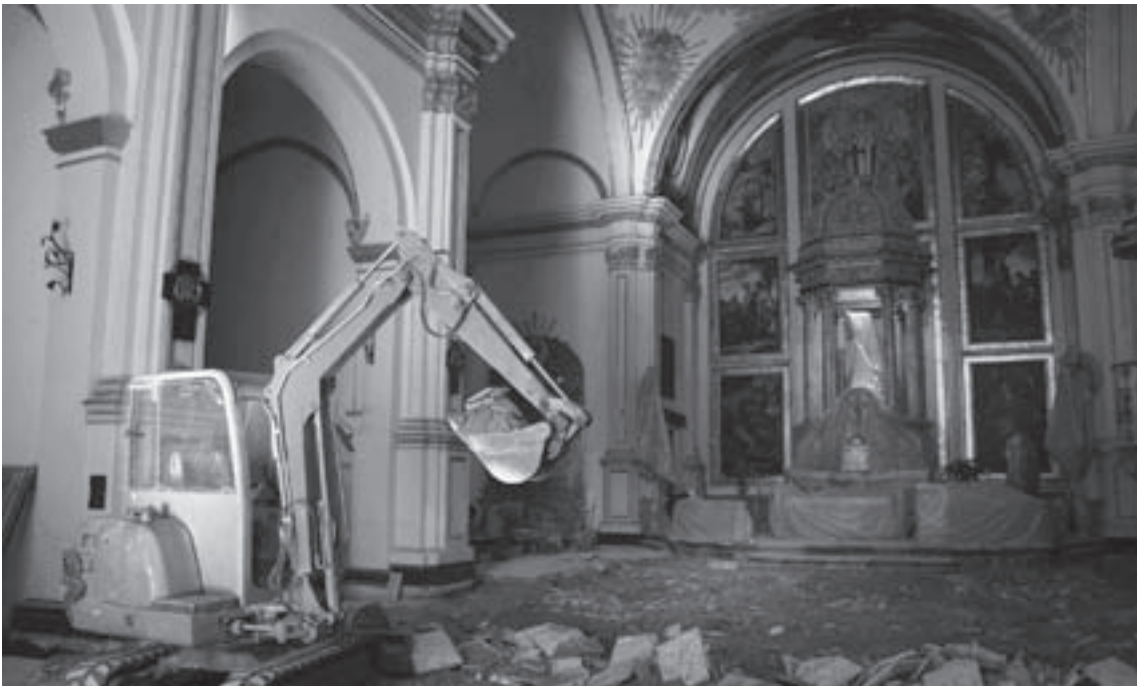
Imagen 15. Trabajos de demolición del pavimento y movimieto de tierra: maquinaria empleada.
