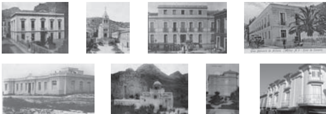
Ejemplos de este movimiento en el Balneario de Archena: el Casino, la Capilla, el Hotel Termas y el Hotel Levante. También los desaparecidos edificios del Sanatorio y Finca la Cerca. El Palacete de Villarrías. Como arquitectura civil urbana destaca la casa de los Marqueses de Corvera.
