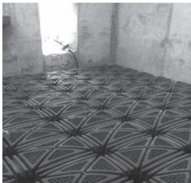
Imagen 6. Forjado de casetones perdidos.
