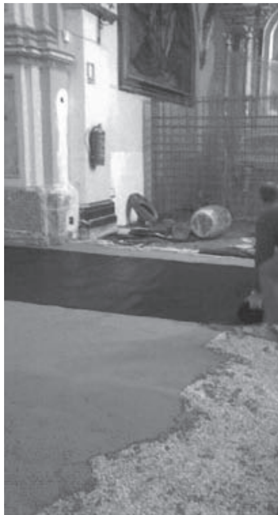
Imagen 17. Capa de mortero para protección de la lámina.
