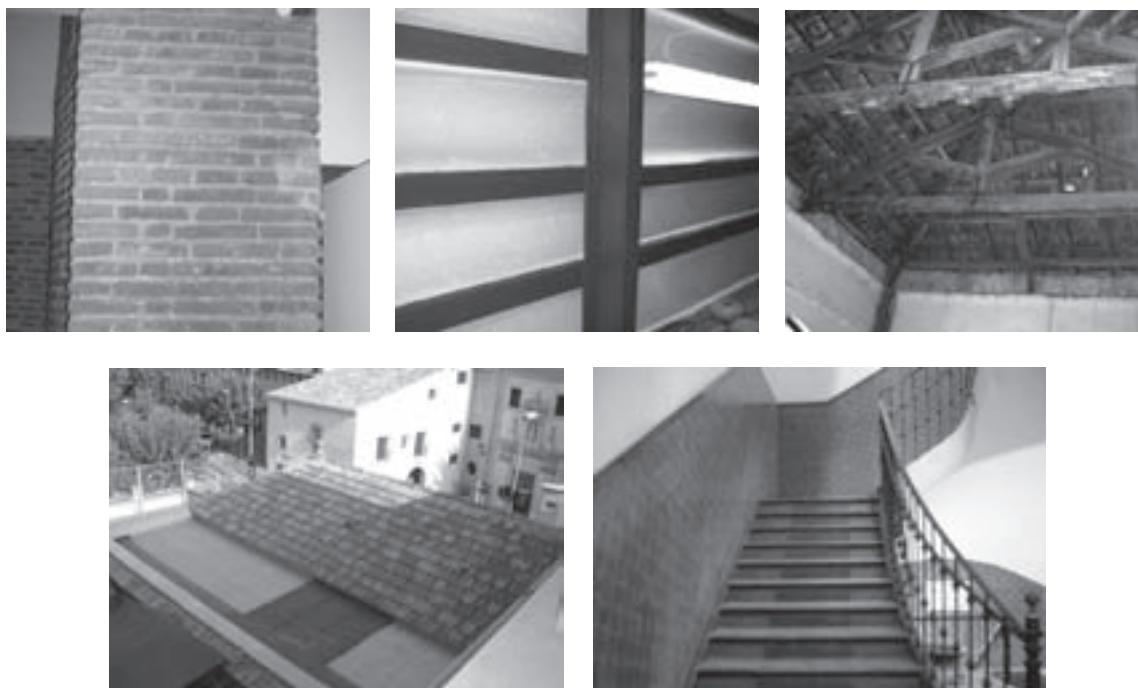
Imágenes de los sistemas constructivos y materiales más usados en el Colegio Público Cierva Peñafiel.
