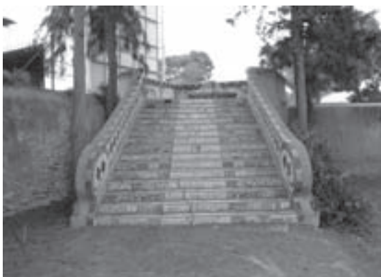
Escalera en trencadís. Finca Torre Llagostera. Cartagena.
