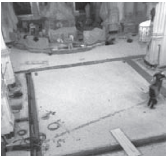
Imagen 16. Cama de grava y tapado de zanjas.
