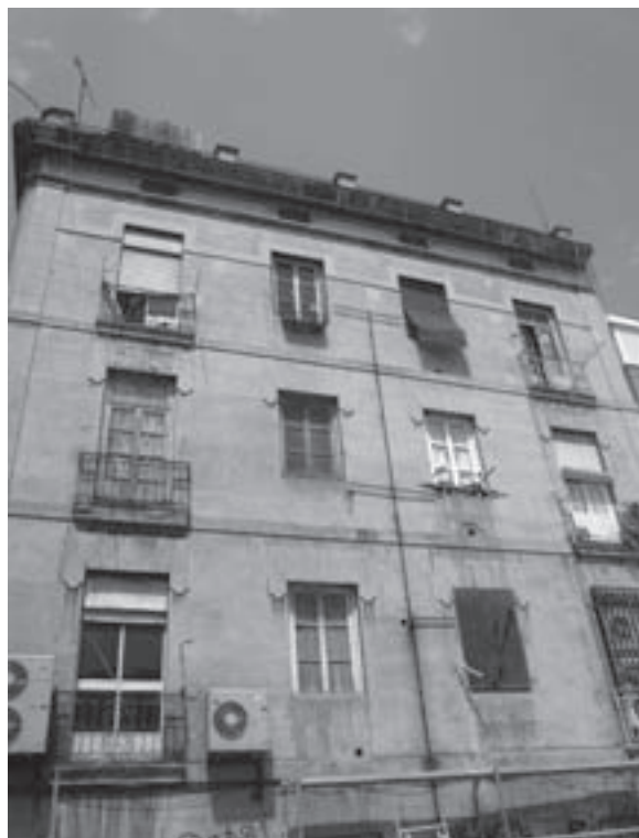
Imagen 2. Fachada trasera, estado inicial.
