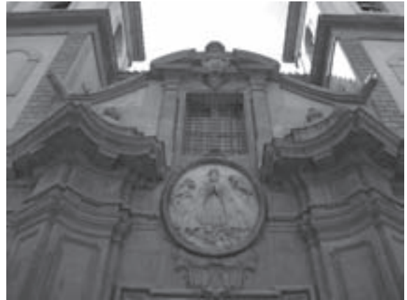
Imagen 3: detalle de la fachada de la iglesia de San Juan de Dios. © Servicio de Patrimonio Histórico, Dirección General de Bellas Artes y Bienes Culturales, Consejería de Cultura y Turismo.
