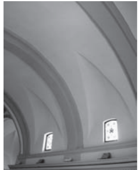
Figura 7. Vista actual de los arcos fajones de la bóveda de cañón con lunetos de la iglesia de San Roque.
