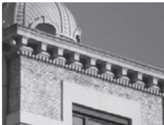
Decoración con piedra caliza en una de las cornisas de este edificio escolar.
