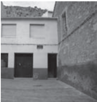
11. Fachada Oeste y edificio anexo antes de las obras. Foto: FJLM.
