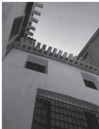
Imagen 4. Fachadas patio interior, tras las obras
