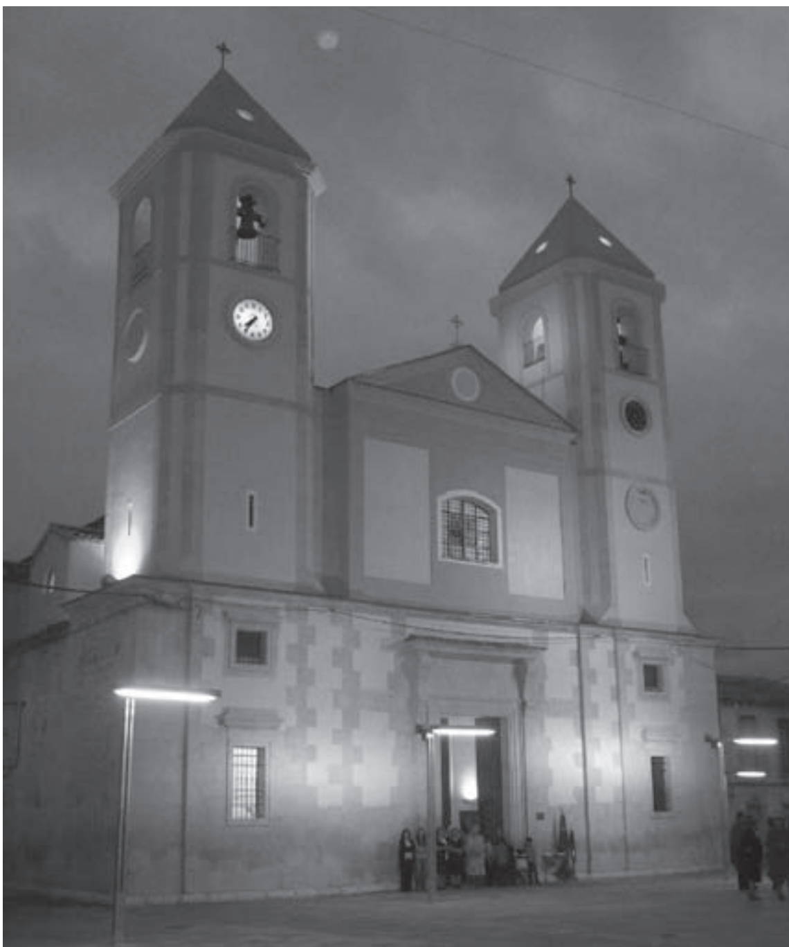
La iglesia, con la iluminación nocturna, tras la finalización de las obras.
