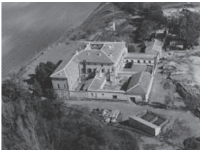
Fig. 1. Vista aérea del Caserón del Carrascalejo.
