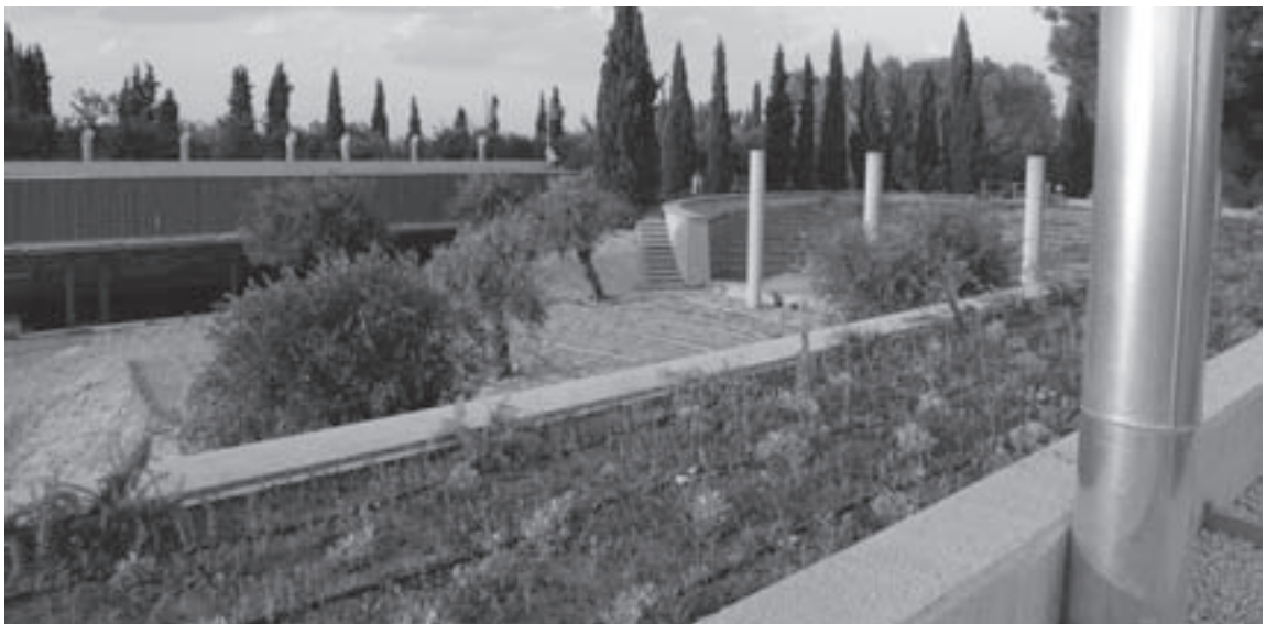
8. Teatro al aire libre y cubiertas verdes de las viviendas bioclimáticas en la actualidad. Conviene recordar que a ambas construcciones les separa 15 años
