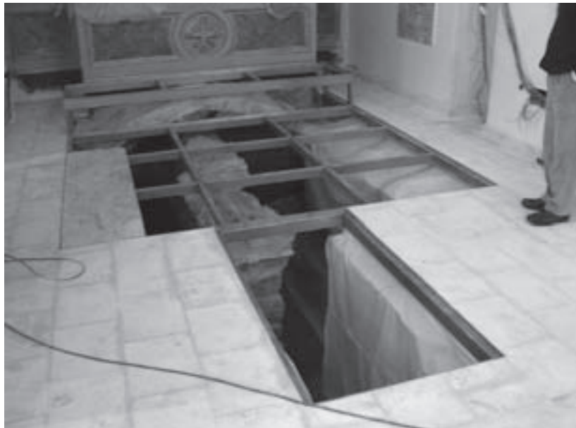
Lámina 8. Montaje de la estructura metálica sobre la cripta
