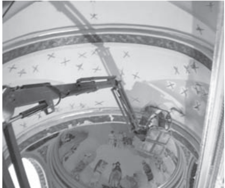
Figura 16. Cosido de grietas en bóveda de la nave central, en el interior del templo.
