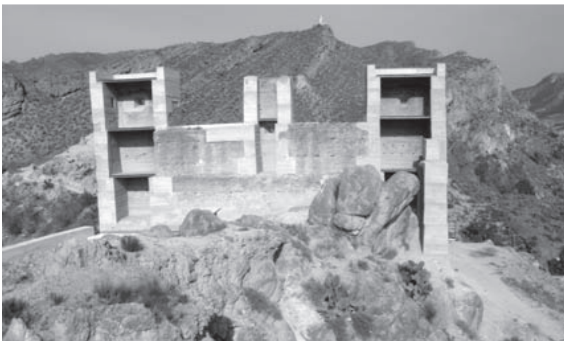
Posterior a la intervención
