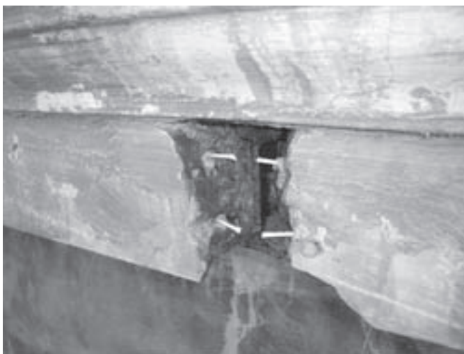
Imagen 8. Reparación de viguetas de cubierta
