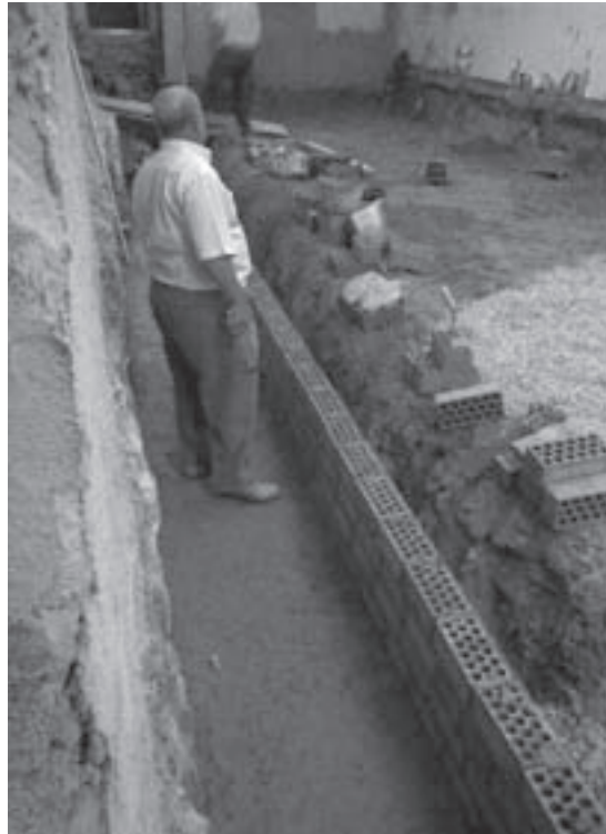
Imagen 8. Ejecución de la prolongación de la zanja hasta el patio interior.
