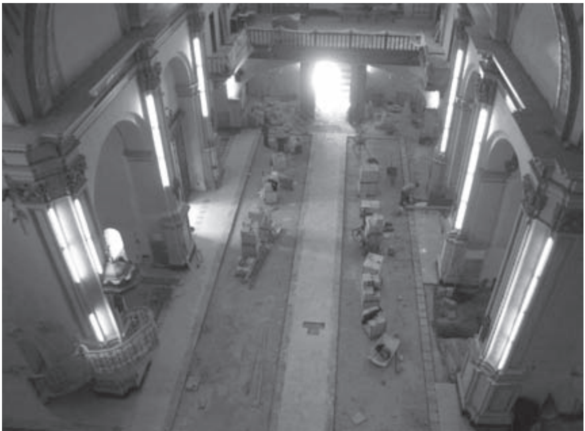
Imagen 18. Vista de la colocación del pavimento en la nave central.
