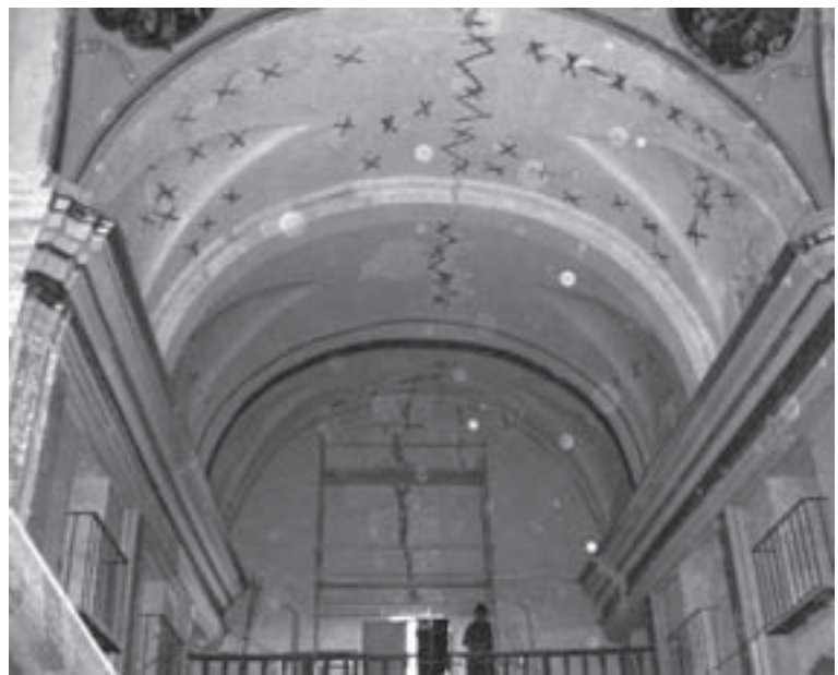
Figura 17. Ejecución del cosido de grietas en la bóveda de la nave central en la fase de corte en aspas del paramento.
