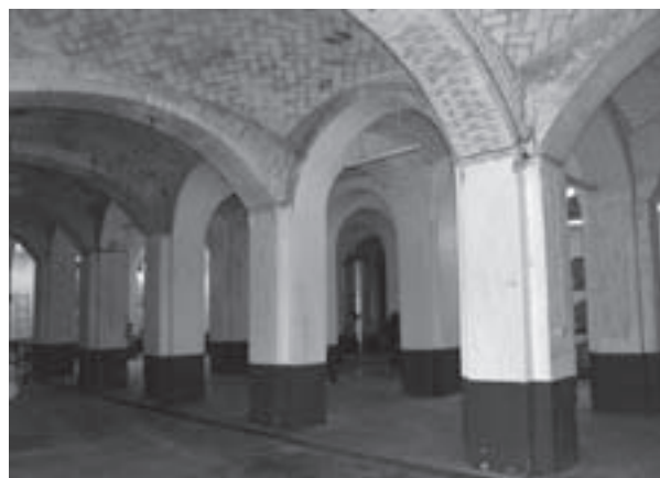
Fig 5. Arcos y bóvedas en la bodega.
