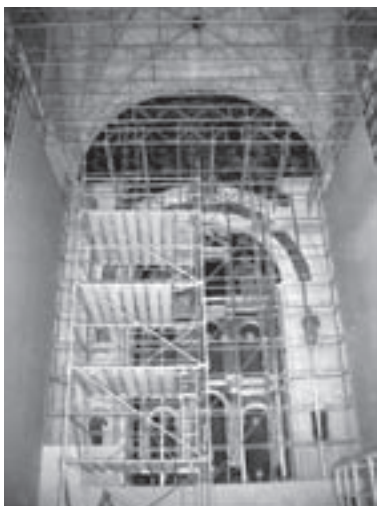
Comienzo de la ejecución de la caja
