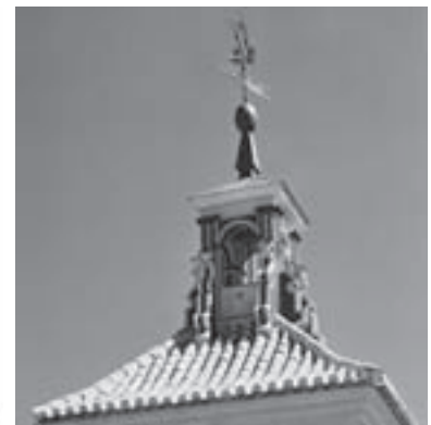
3. Remate de la torre después de las obras. Foto: FJLM.
