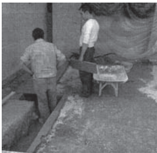
Imagen 13. Ejecución de zanjas en capillas.
