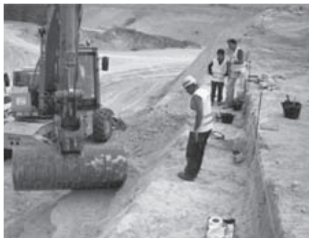
Fig. 8. Acondicionamiento del talud VLP2 en la zona en la que se realizó la excavación sistemática.
