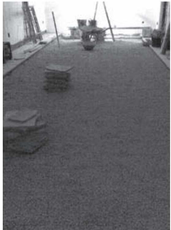
Imagen 10. Perímetro solado a trabajuntas y cama de grava.
