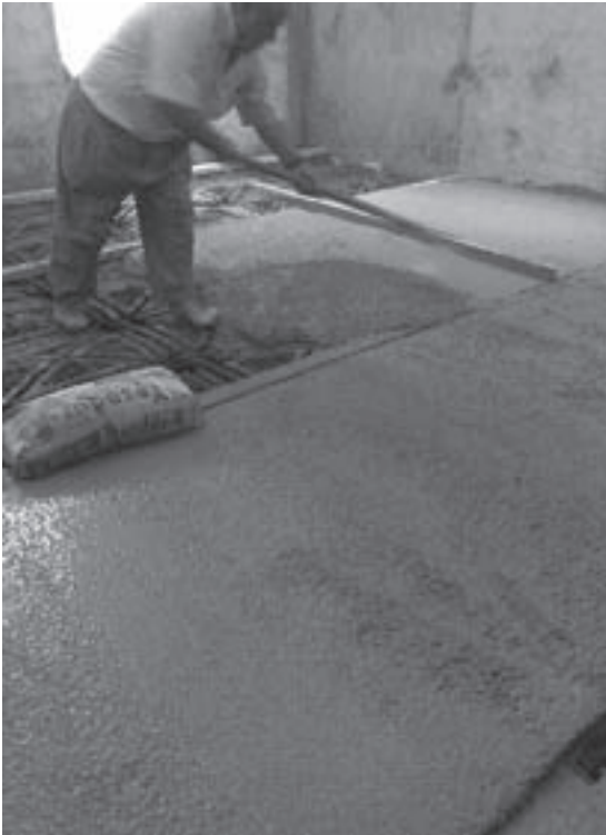
Imagen 7. Vertido de hormigón sobre mallazo y casetón perdido.
