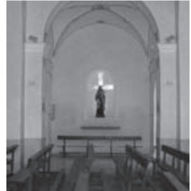
7. Muro Sur, vista interior. Ejemplo de actuación para recuperar el lugar de los antiguos altares. Foto: FJLM.
