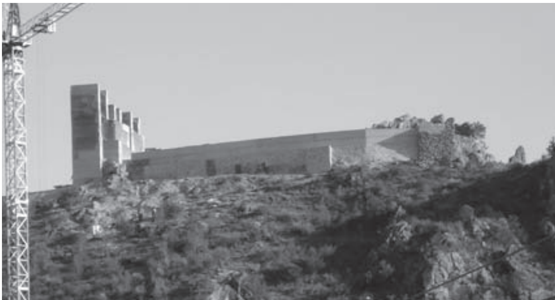
Posterior a la intervención
