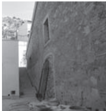
12. Fachada Oeste y edificio anexo casi al final de las obras. Foto: FJLM.
