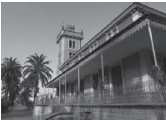
Vista de la Torre Llagostera desde el mirador.
