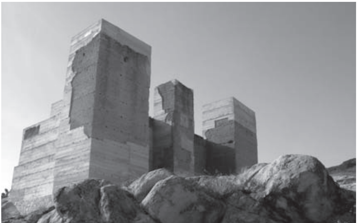
Posterior a la intervención
