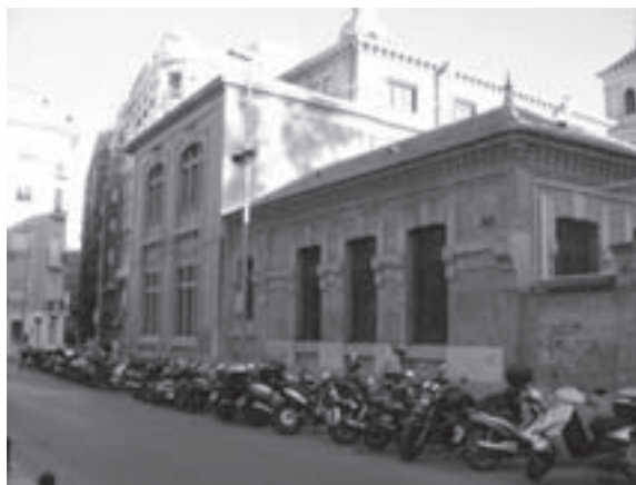
Aspecto de una de las fachadas laterales.
