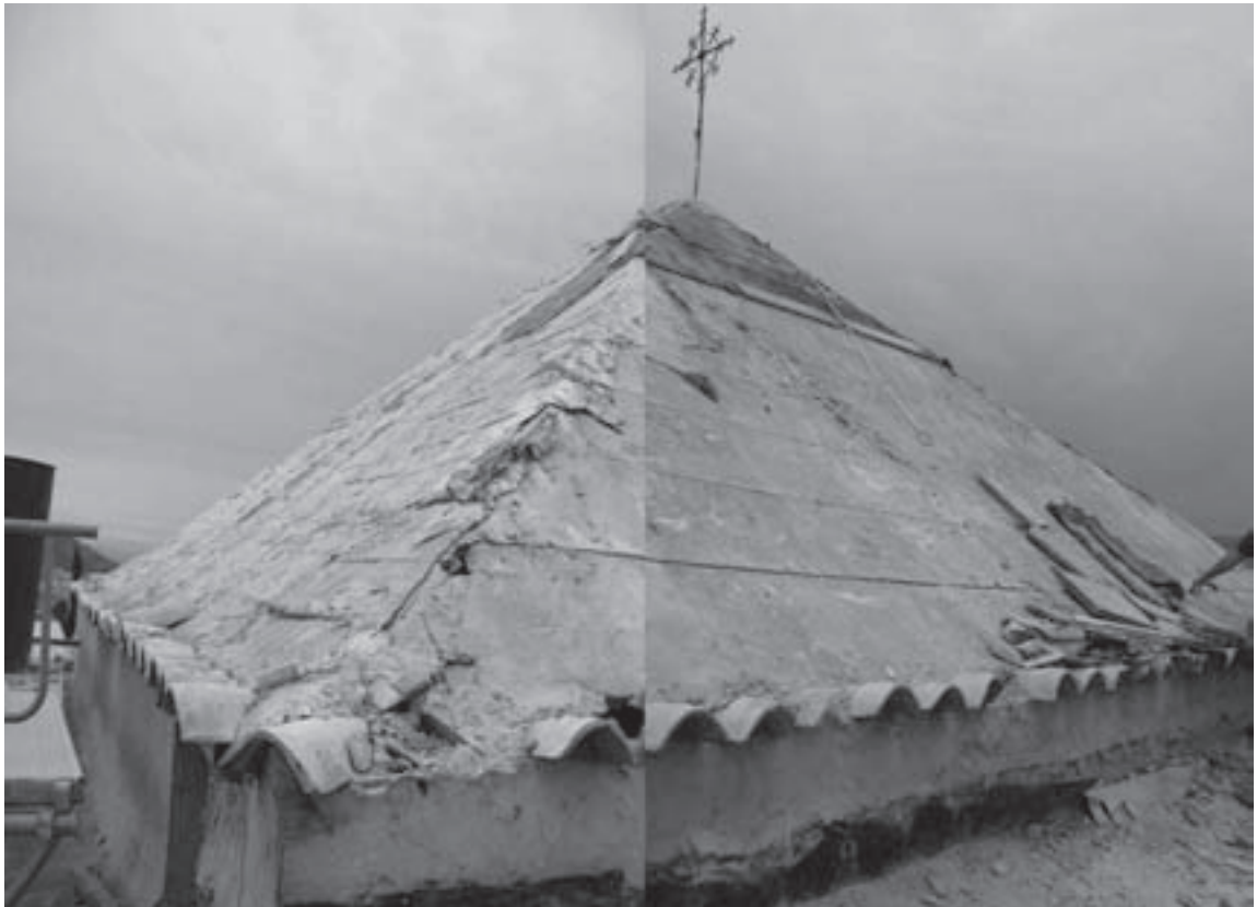
La cubierta del presbiterio, una vez desmontada la teja y la capa de compresión de hormigón, bajo la cual había unas telas asfálticas, que aún impedían más la ventilación.
