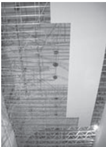
Colocación del techo
