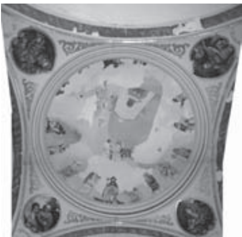
Figura 5. Cúpula bajo pechinas antes de la reciente restauración.
