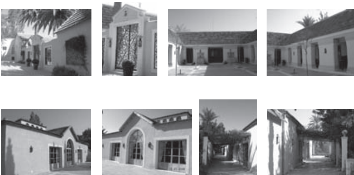
Rehabilitación y ampliación del edificio de las Caballerizas.
