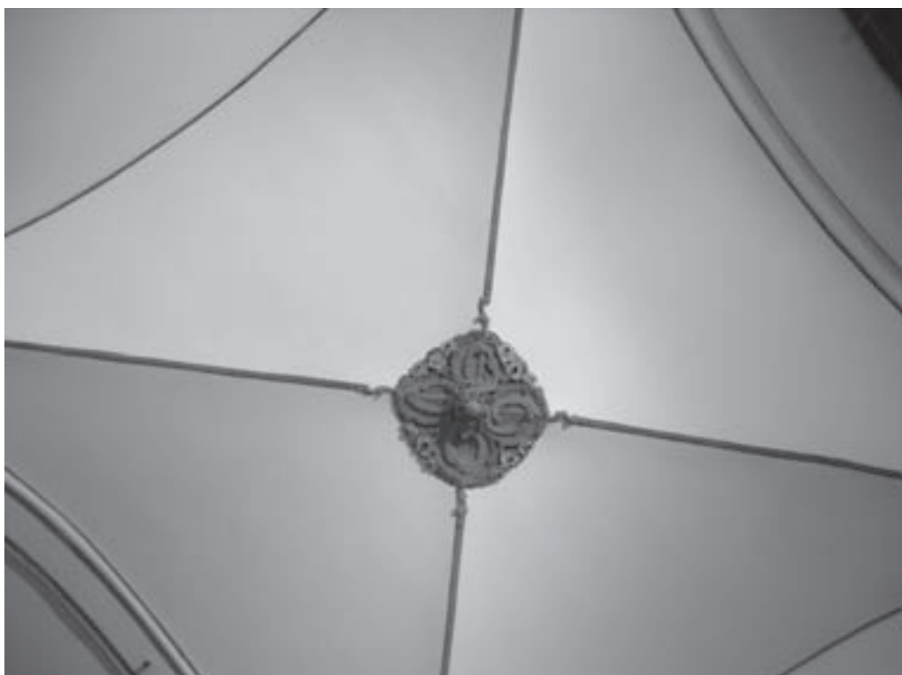
Foto 2. Resultado final de una de las bóvedas de la Capilla anexa.
