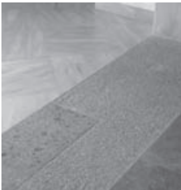
8. Detalle de los nuevos pavimentos de la iglesia. Foto: FJLM.
