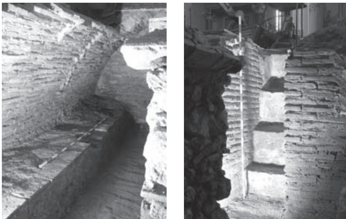
Lámina 4 y 5. Detalle de la bóveda, rebanco y escalera de acceso a la cripta.
