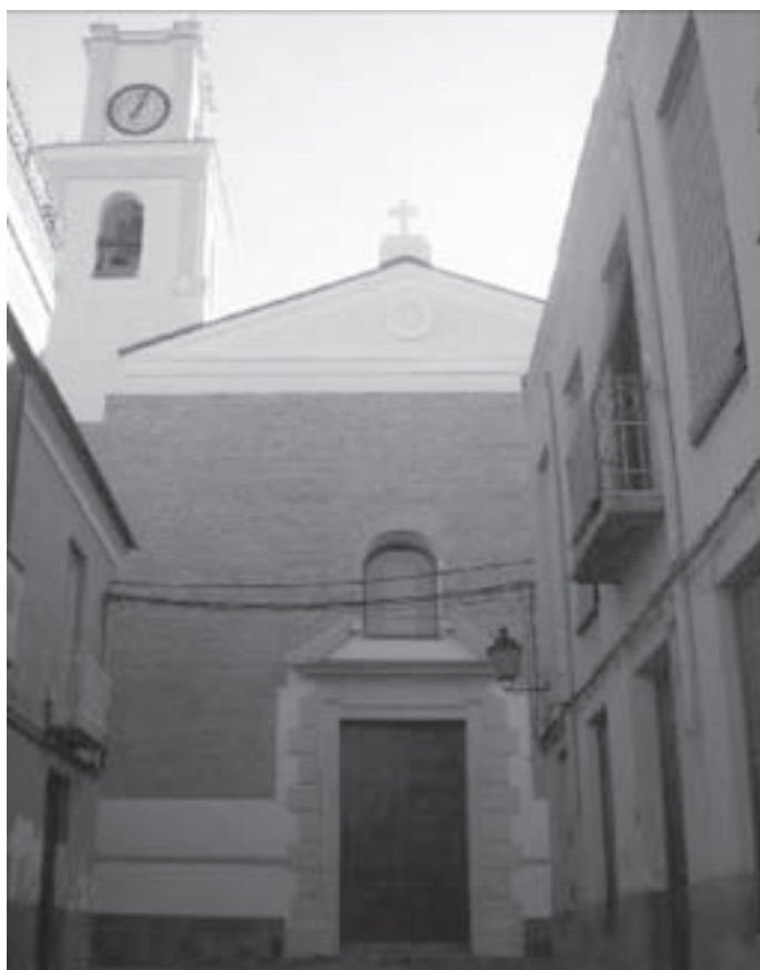
Figura 18. Fachada principal después de la intervención.
