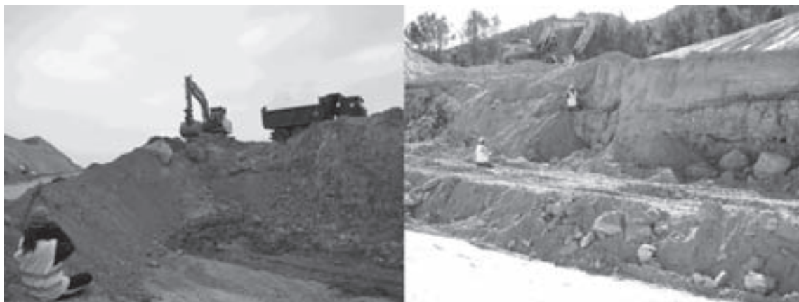
Fig. 7. Seguimiento paleontológico en la zona de carga del sedimento (A). Recuperación de restos en taludes modificados por la maquinaria (B).
