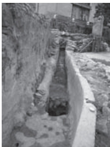
El corredor aliviadero una vez recrecido para las obras de entubamiento (F. 5); Limpieza del viejo rodete (F.6)
