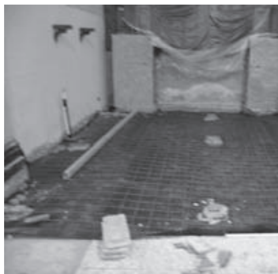
Imagen 14. Capilla lista para el hormigonado.
