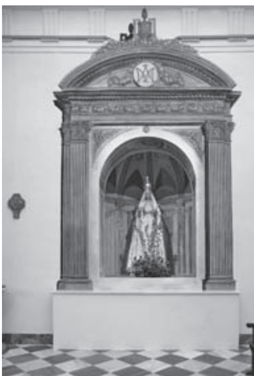
Imágenes durante las obras de restauración.
