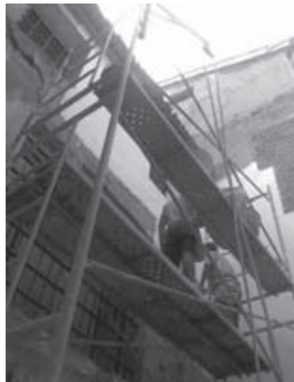
Imagen 3. Trabajos en fachadas, patio interior
