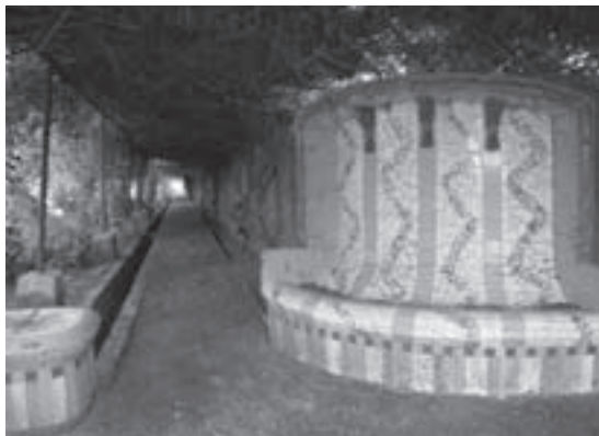
Trabajos en trencadís en el jardín de la Torre Llagostera. Cartagena.
