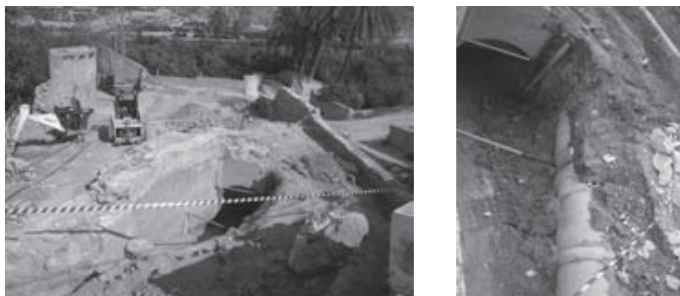
El entubamiento de la acequia en ese tramo destruyó la mitad del cubo. (F.1 y F.2)
