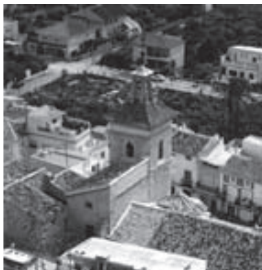
1. Imagen de la iglesia en 1999, antes del comienzo de las obras. Foto: FJLM.
