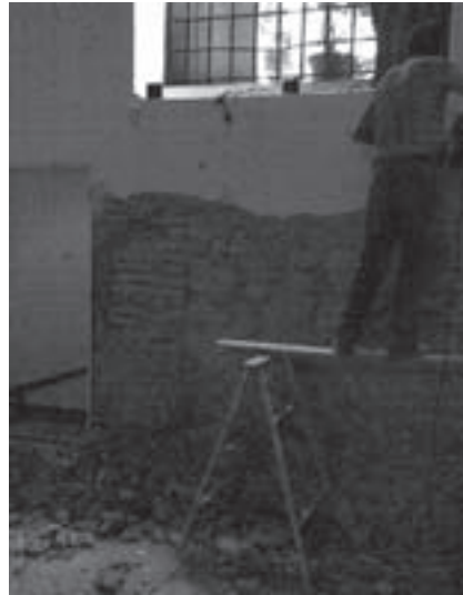
Imagen 2. Picado de paramentos verticales.
