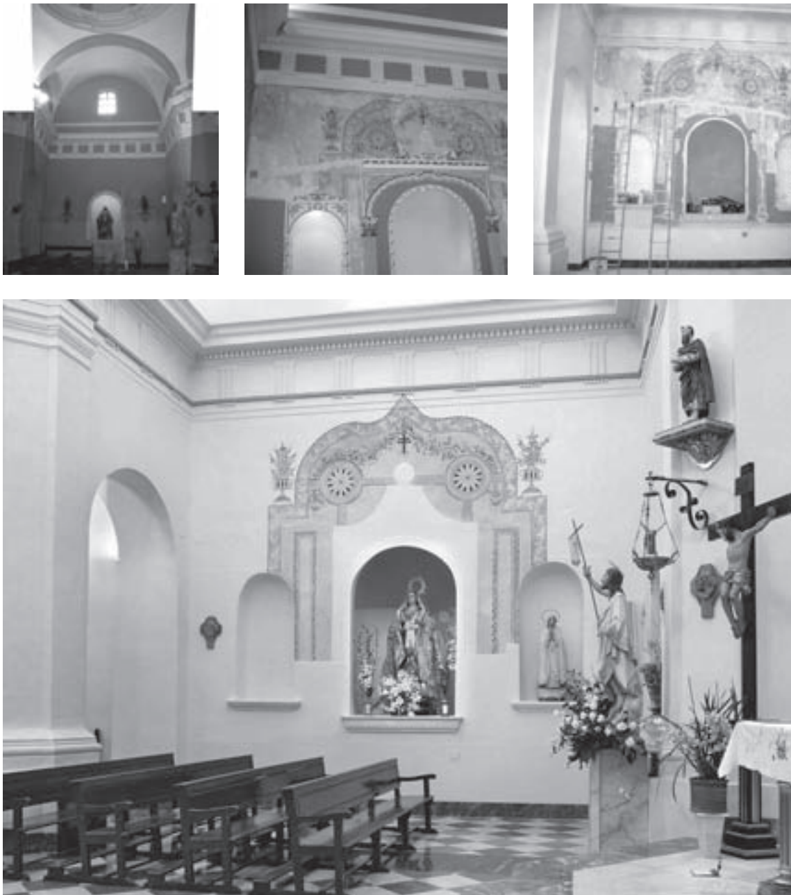
Imágenes durante las obras de restauración.
