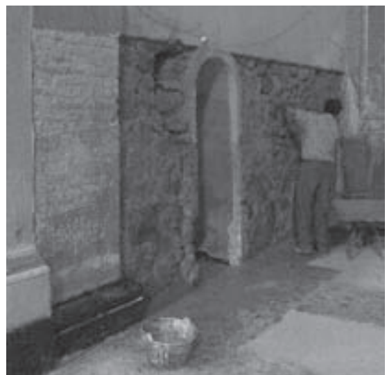
Imagen 11. Actuaciones sobre muros.
