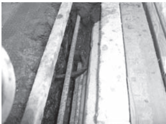
Imagen 10. Reparación de losas de balcones
