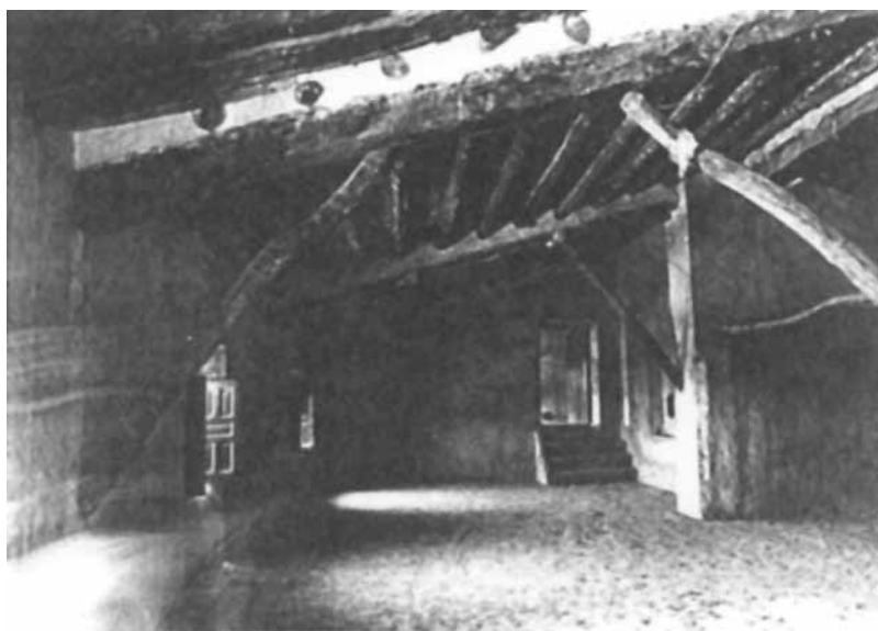
Figura 8. Estructura de cubierta de rollizos de madera.
