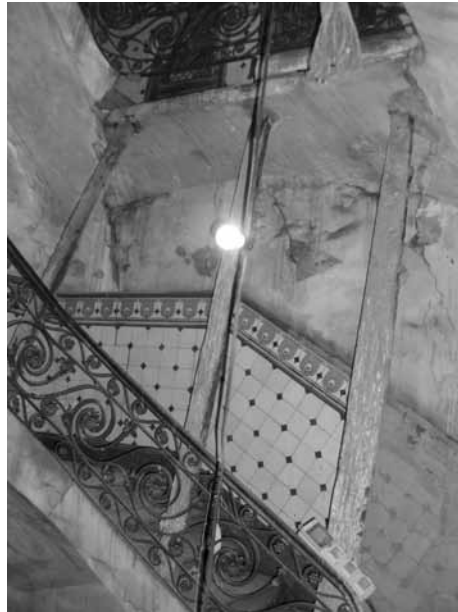
Figura 2. Apuntalamiento del interior del edificio durante los años 70.
