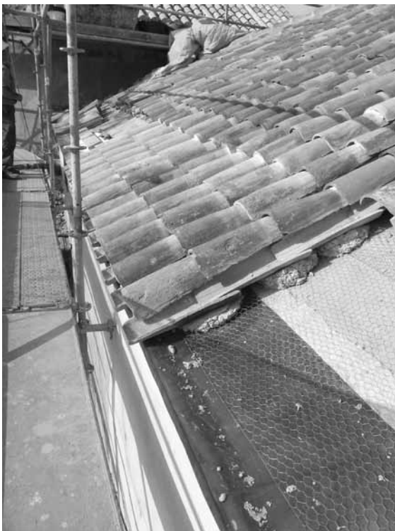
Proceso de montaje: Figura 14. tableros sobre la estructura. Figura 15. emplomado sobre el alero y tela de gallinero. Figura 16. Colocación de la teja. Figura 17. Vista por debajo del alero, ya plegado.
