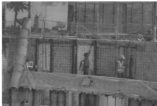
Figura 20. Trabajos de saneamiento y refuerzo de muros.
