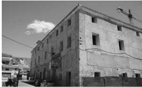
Figura 2. Vista exterior de las crujiás oeste y sur del Convento de San Francisco de Mula. Fotografía: Juan García Sandoval.
