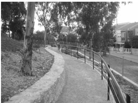
Figura 7. Estado final del camino interior del Cerro.
