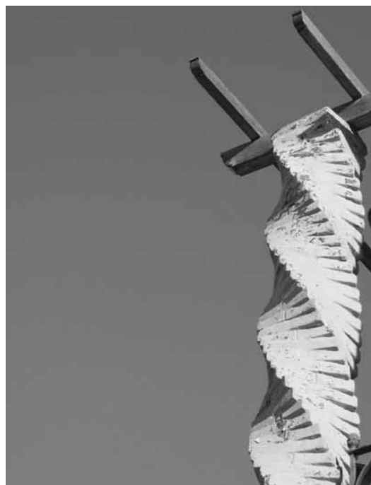
Figura 4. Detalle columna helicoidal de ladrillo.
