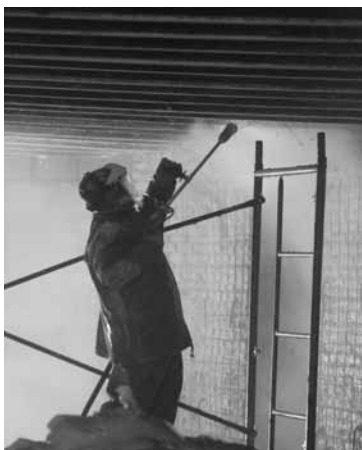
Figura 30. Chorro de agua, limpieza y saneamiento vigas primer anfiteatro.
