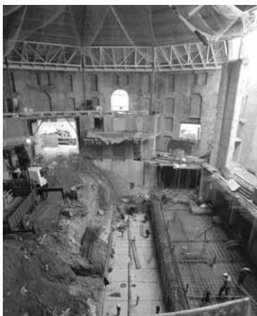
Figura 26. Escavación y losas de cimentación de foso de orquesta y sótano.
