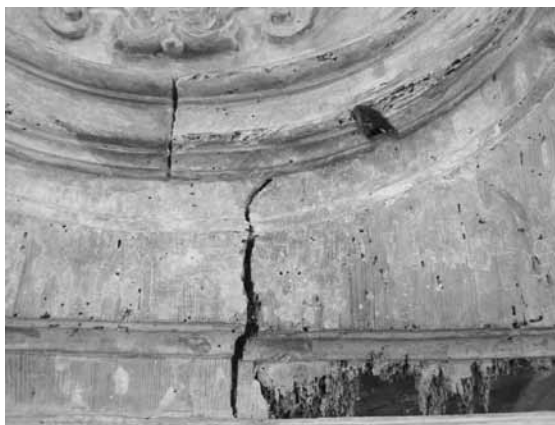
Figura 5. Detalle del proceso de limpieza y eliminación de estucos antiguos en mal estado de conservación en una de las puertas.
