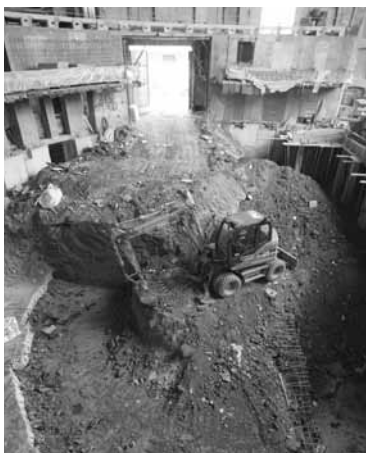
Figura 23. Imagen movimiento de tierras sala principal.
