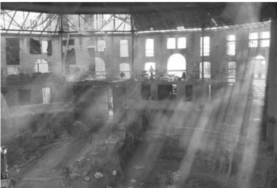
Figura 21. Aspecto de la sala principal en la primera fase de desescombro y saneamiento inicial.
