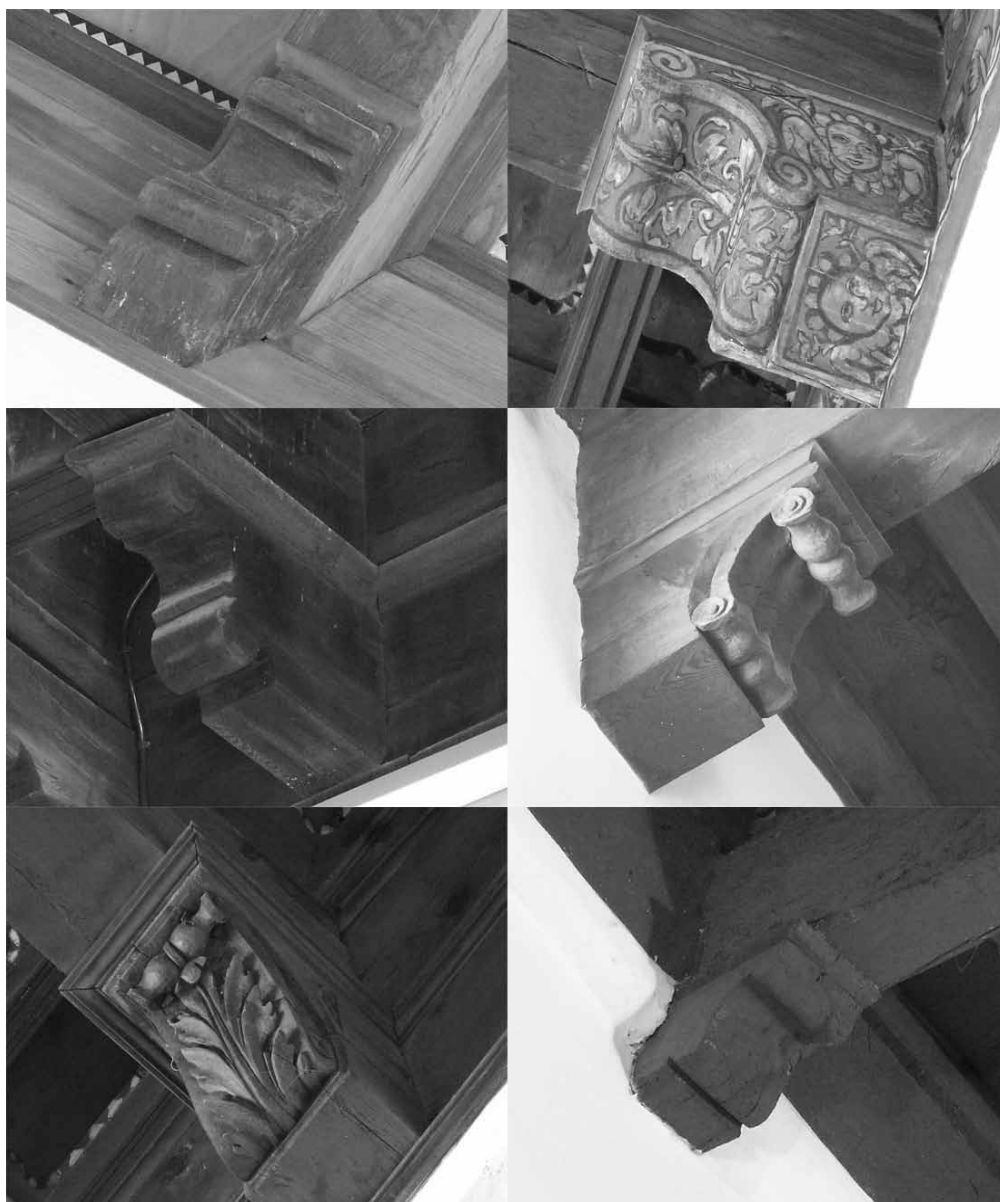
Figura 9. Ejemplos de elementos característicos de las estructuras y su ornamentación, como canes y tocaduras. De arriba abajo y de izquierda a derecha: San Bartolomé de Ulea, la Concepción de Cehegín, San Andrés de Mazarrón, Santiago de Totana, la Concepción de Caravaca y San Roque de Yecla.
