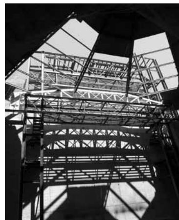
Figura 28. Estructura final nuevo peine.
