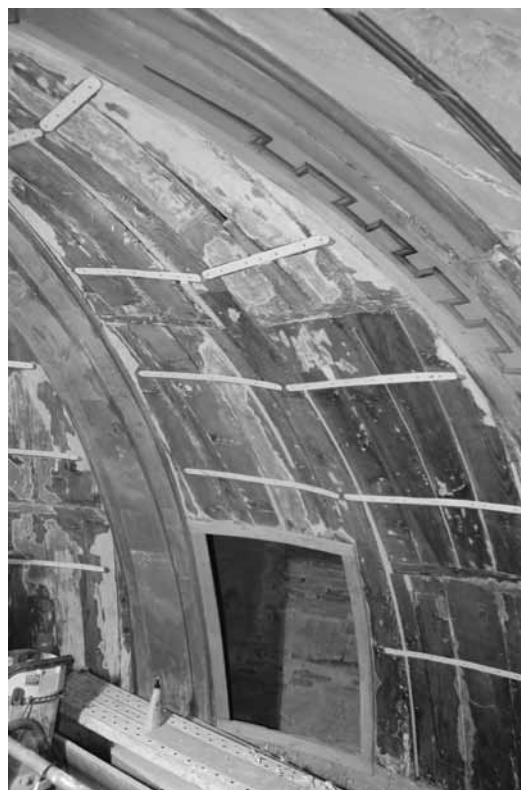
Figura 4. Paño de la bóveda con todas las pletinas fijadas
