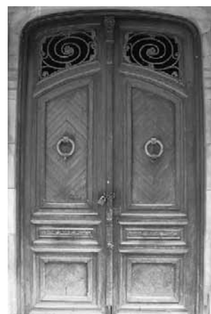
Figura 6. Exterior de puerta principal.
