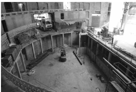
Figura 8. Proceso de obra construcción foso de orquesta y plataforma patio de butacas 1.
