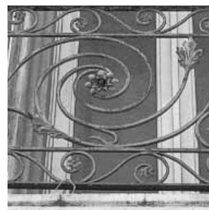
Figura 11. Distintos materiales constructivos.
