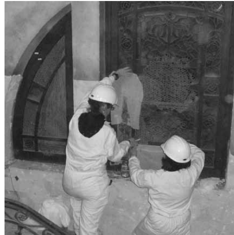
Figura 15. colocación de protección de vidriera por técnicos especializados.
