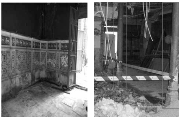
Figura 7. Zócalo de piedra natural y pilares metálicos de planta baja.
