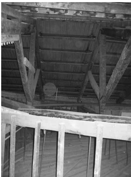
Figura 4 donde se aprecian dos cerchas, las correas entre ellas y el tablero de uralita
