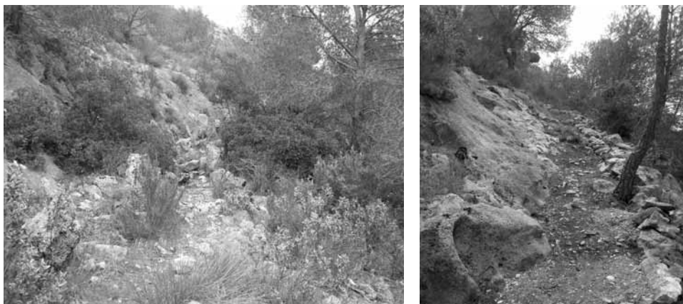
Figuras 9 y 10. Estado del camino de acceso a los abrigos antes y después de la actuación.
