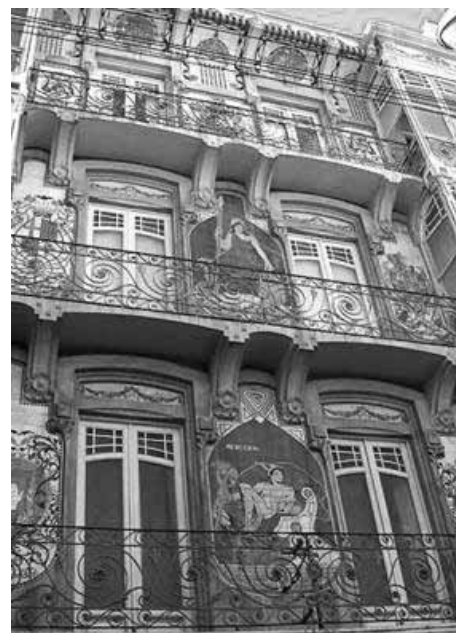
Figura 4. Fachada principal de la Casa Llagostera.
