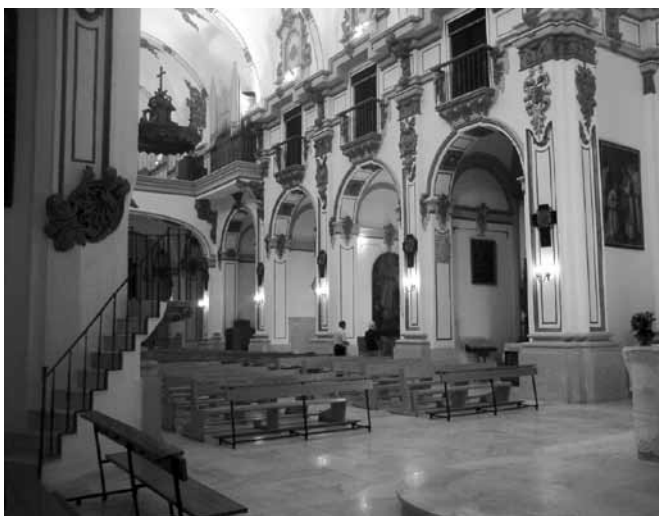
Figura 2. Estado final de la iglesia.
