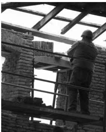
Figura 27. Reparación dinteles de ladrillos de las ventanas.
