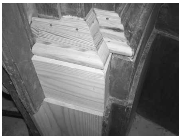
Figura 6. Sustitución de elementos de madera.
