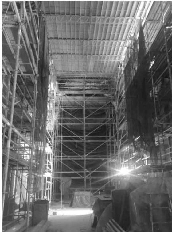
Figura 1. Estado de la iglesia durante las obras.
