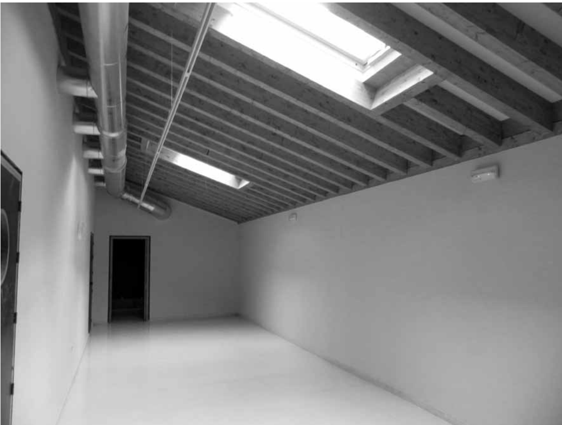
Figuras 36 a 38 en las que aparece una de las salas de acceso a la zona de gallinero o paraíso en su estado previo (arriba a la izquierda), durante las obras, una vez retirado el falso techo Armstrong y, finalmente, el estado una vez terminados los trabajos en la nueva cubierta, los lucernarios, solado y paramentos (el aire acondicionado es posterior a la obra).
