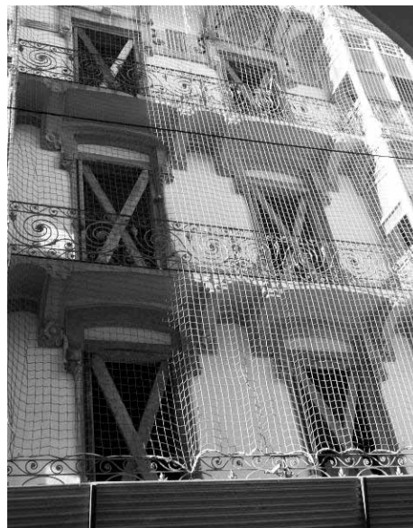
Figura 3. Protección del azulejo de la fachada principal.
