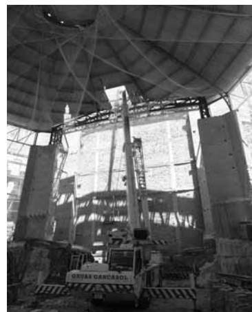
Figura 25. Desmontaje peine original mediante grúa móvil.
