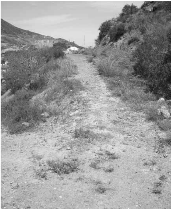
Figura 3. Imagen del estado de conservación, previo a la intervención, de un tramo del camino en el Cerro del Molinete. Al fondo aparece el Castillo de los Vélez.
