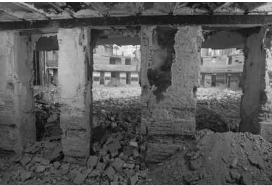
Figura 19. Aspecto inicial primeros trabajos de desescombro.
