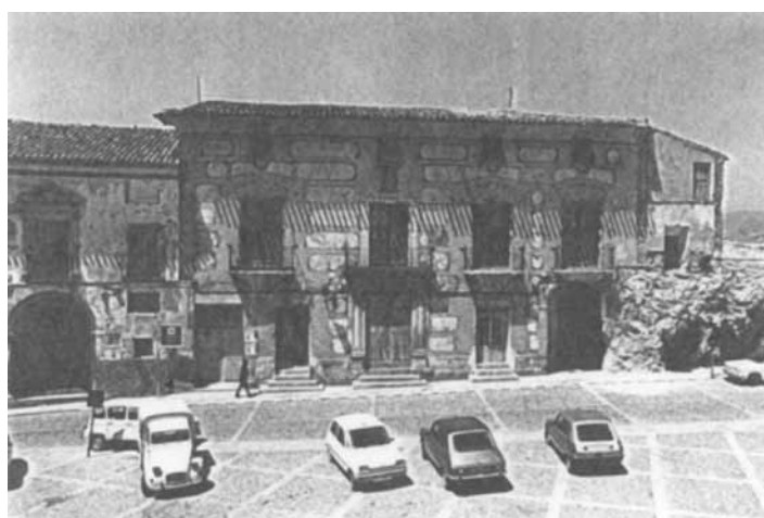
Figura 4. Fotografía de 1978 que muestra el estado en que quedó el Palacio tras la demolición del castillo junto con el segundo cuerpo que se adosaba a la Torre del Homenaje.
