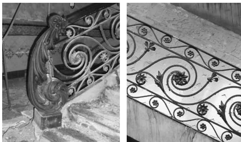
Figura 10. Detalle de pilastra de arranque de escalera y de cerrajería.
