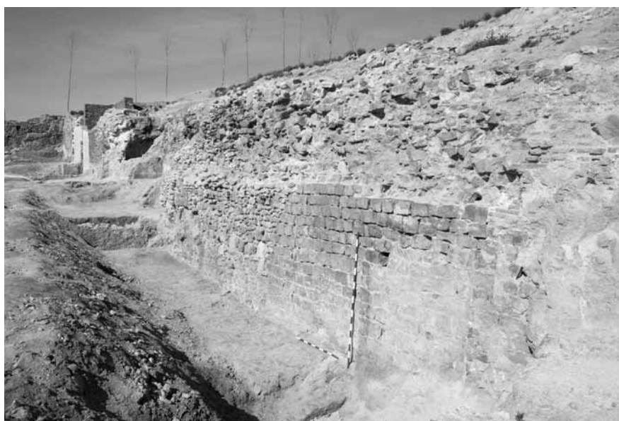
Figura 6. Vista general del muro de aterrazamiento al comenzar los trabajos de restauración (Foto: J. Gómez Carrasco).
