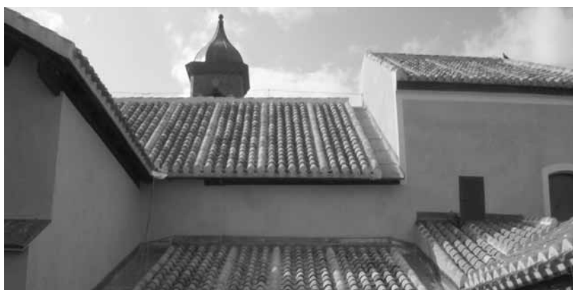
Figuras 5, 6 y 7, correspondientes a la zona Norte, con el estado previo de faldones, paramentos y aleros (arriba), durante las obras (centro) y, abajo, el estado una vez concluidos los trabajos
