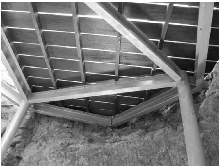
Figura 9. Detalle de la estructura metálica y de madera del interior de la Torre del Molinete.
