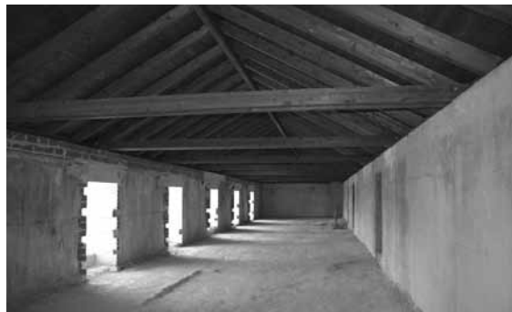
Figura 6. Segunda planta, crujía oeste. Corresponde al último piso con tejado a dos aguas y techo de madera. Fotografía: Juan García Sandoval.
