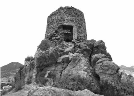
Figura 1. Imagen general de la Torre del Molinete antes de la restauración.
