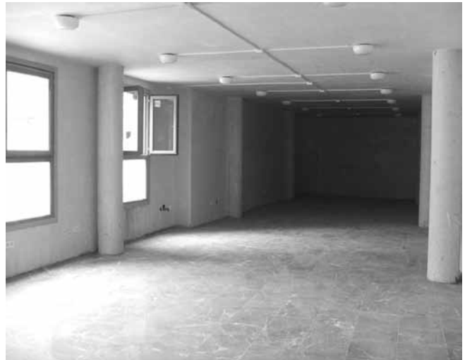
Figura 4. Estado del archivo durante las obras.
