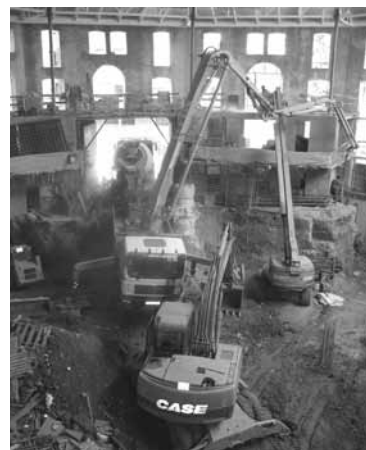
Figura 31. Maquinaria en el interior del Teatro, proceso de obra.
