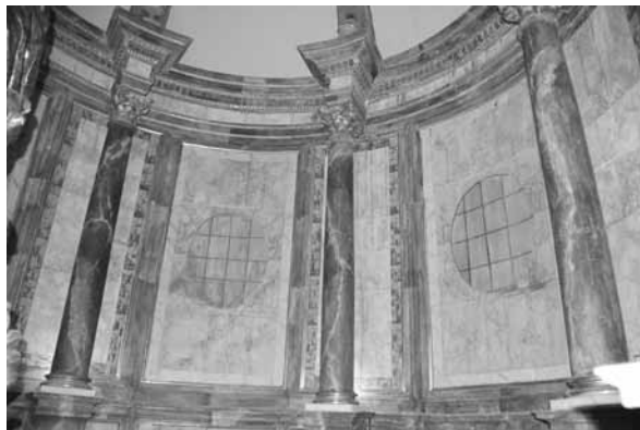
Figura 8. Aspecto final de la intervención.
