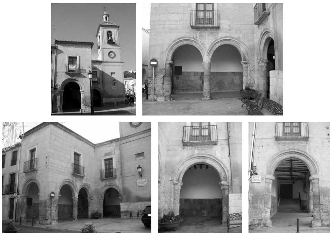
Figura 1. Pórtico del Edificio del Pósito de la Plaza Mayor de Yecla.
