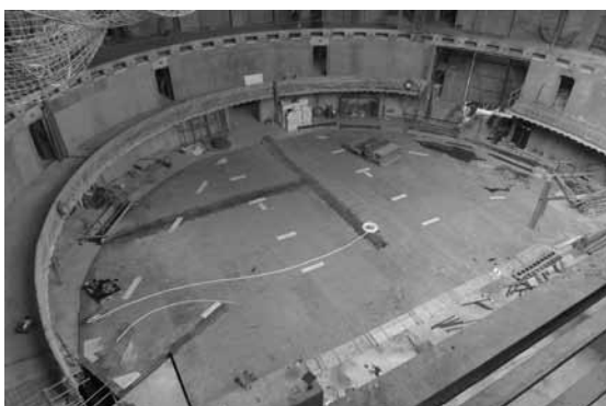
Figura 10. Proceso de obra construcción foso de orquesta y plataforma patio de butacas 3.
