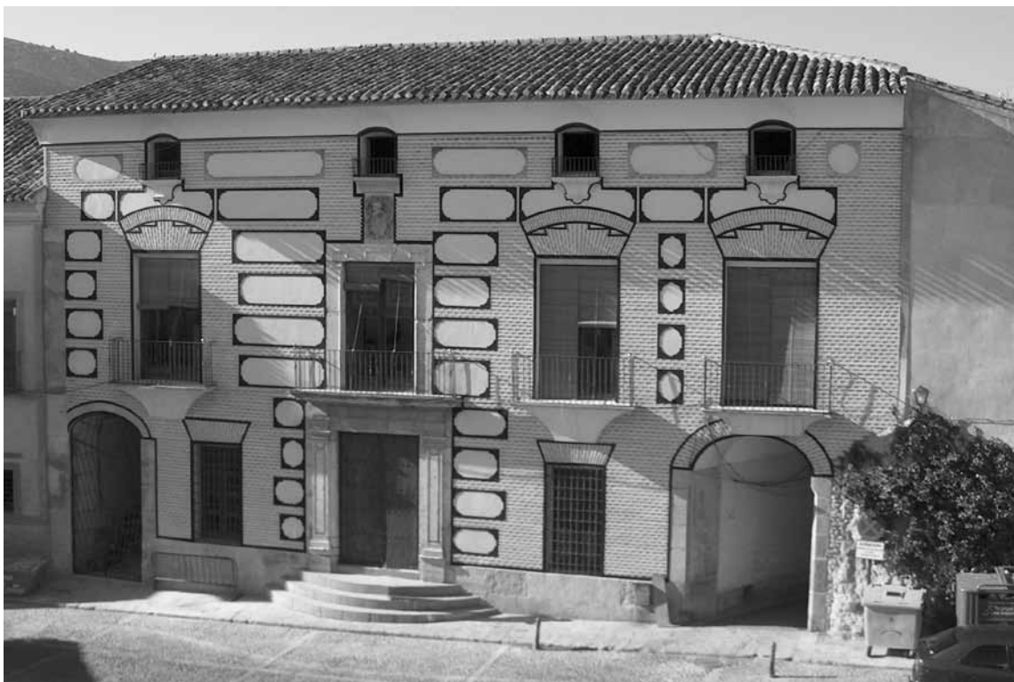
Figura 9. Estado actual de la fachada tras su restauración.
