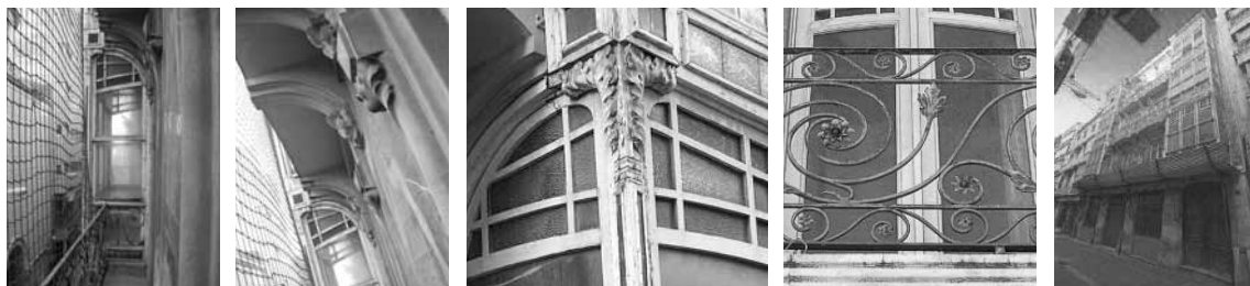
Figura 5: Detalles de la fachada principal, en madera, piedra y rejería de forja, donde se observa la variedad de elementos vegetales utilizados en su ornamentación.
