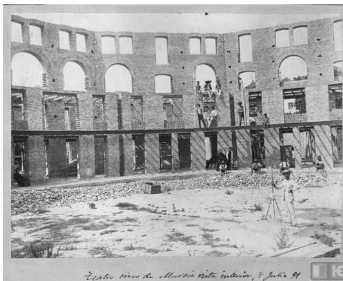
Figura 1._Construcción Teatro Circo Murcia, 8 de julio de 1891.
