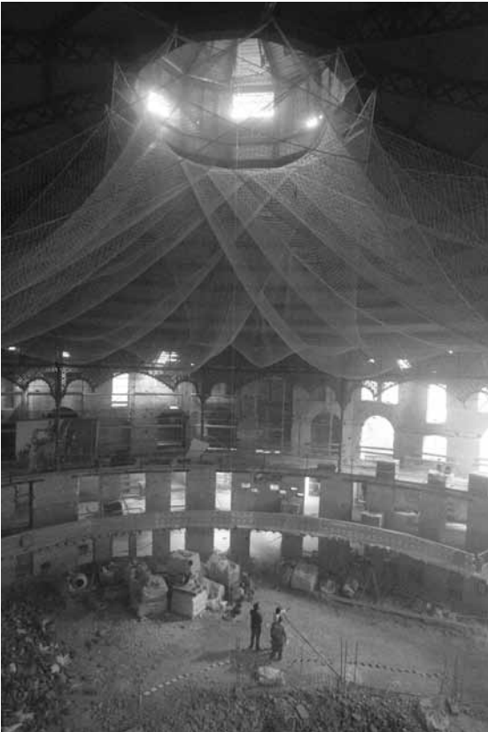
Figura 18. Imagen de la cúpula y patio de butacas durante el proceso de obra.
