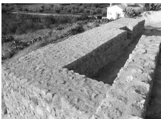
Lámina 9 y 10. Restauración de la canalización y barbana.
