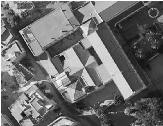
Figura 3. Vista general de las cubiertas de la Iglesia y locales parroquiales anexos. Hemos señalado los tres puntos donde se produce mayor dificultad en la salida de las aguas, al estar los mismos en lima hoyas hacia el interior del complejo y, por tanto, ser necesarios canalones y bajantes que, antes de la ejecución de las obras estaban mal resueltos en algunos casos, atascados en otros y con dificultad de mantenimiento en todos los casos.
