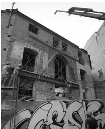
Figura 29. Colocación viga cargadero fachada lateral.
