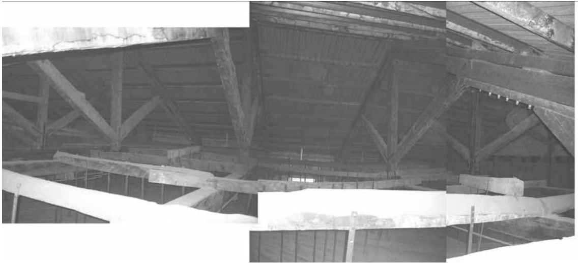
Figura 10: Montaje fotográfico para apreciar las cerchas, colgado de ellas el techo pictórico dispuesto en lienzo sobre el de cañizo y, sobre ellas, la Uralita y la losa de hormigón.
