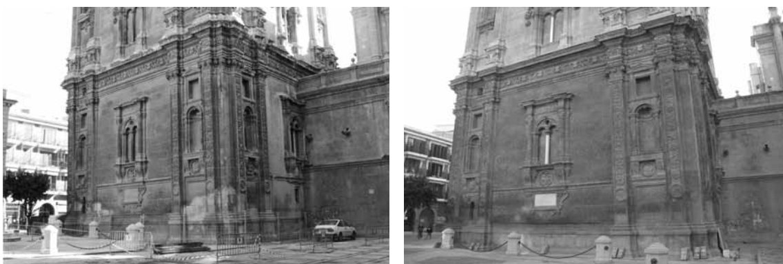
Figuras 1 y 2. Vistas del primer cuerpo de la torre desde su vértice NW tras la actuación realizada para la exposición Huellas 2002 (Foto Juan Antonio Molina Serrano) y finalizada las actuaciones en enero de 2010, fachada N. (Foto Juan Carlos Molina Gaitán)
