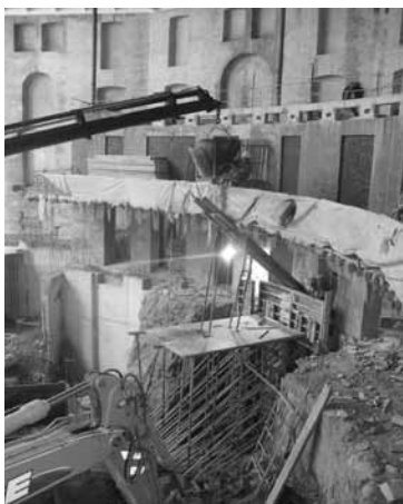
Figura 24. Imagen realización muro contención hormigón perimetral por bataches.
