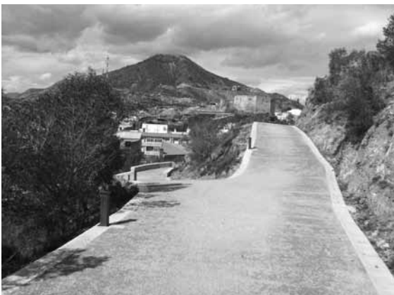
Figura 5. Estado final del camino, con el Castillo de los Vélez al fondo.
