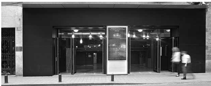
Figura 13. Entrada principal al Teatro, embocadura de entrada.
