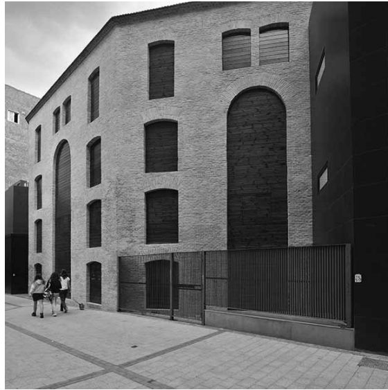
Figura 12. Aspecto final de la fachada una vez restaurada.
