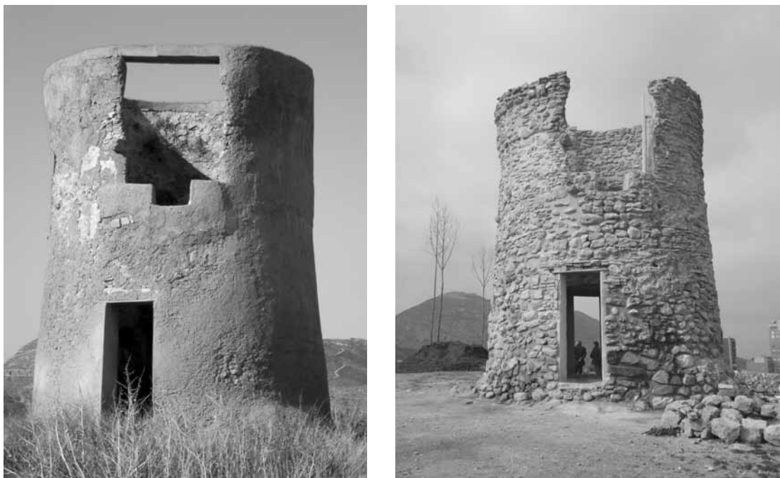
Figuras 14a y 14b. Diferentes imágenes del molino del sector A antes y después del proceso de conservación-restauración.
