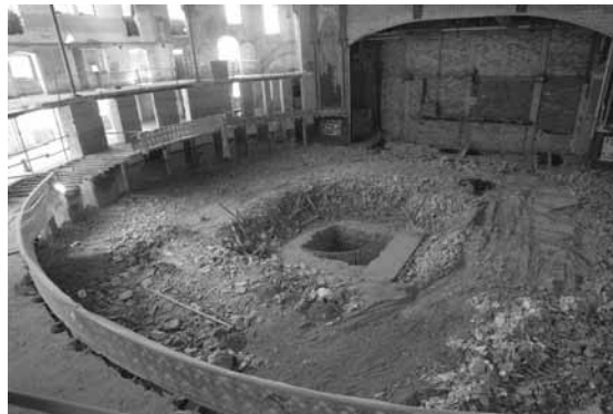
Figura 22. Imagen de la sala principal con el escombro acumulado de la fase inicial.
