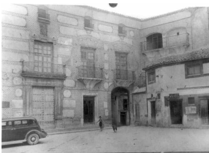
Figura 3. Fotografía de 1927 donde se muestra la fachada principal.
