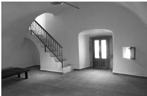
Figura 7. Planta alta de la torre, tras la intervención.
