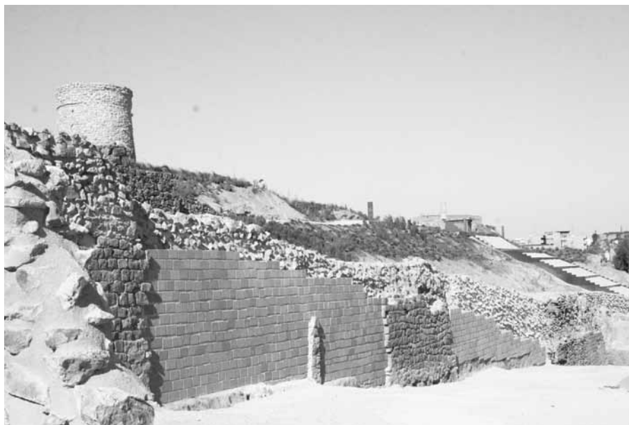
Figura 8. Perspectiva del muro de aterrazamiento ya restaurado, asociado a las escalinatas de acceso al templo.
