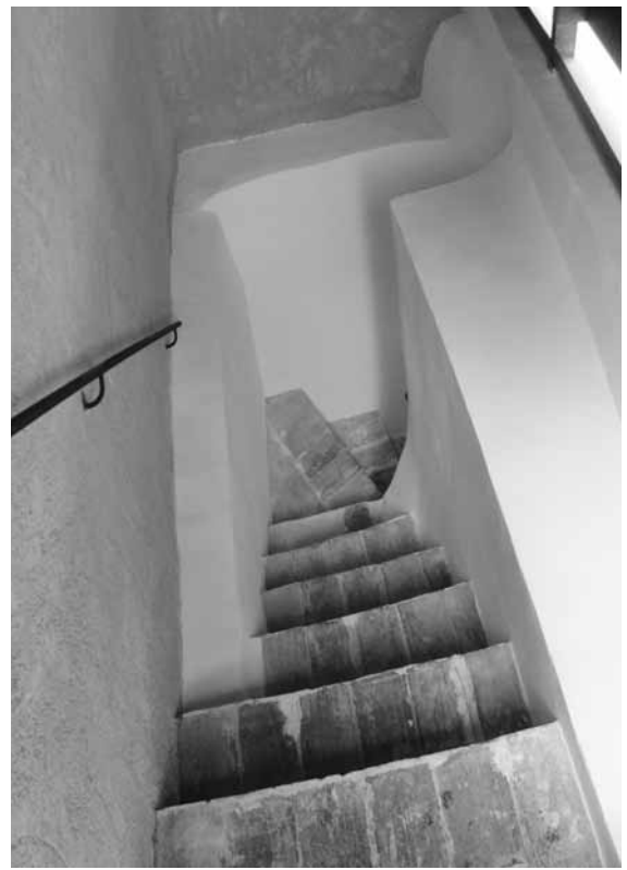
Figura 8. Interior del tramo de escalera de acceso a cubierta.
