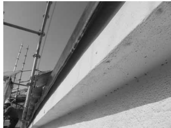
Proceso de montaje: Figura 14. tableros sobre la estructura. Figura 15. emplomado sobre el alero y tela de gallinero. Figura 16. Colocación de la teja. Figura 17. Vista por debajo del alero, ya plegado.
