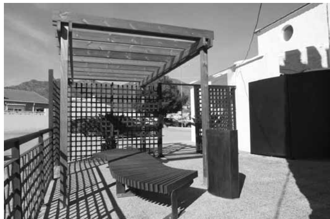
Figura 10. Vista general del patio de acceso a la Torre después de la intervención.
