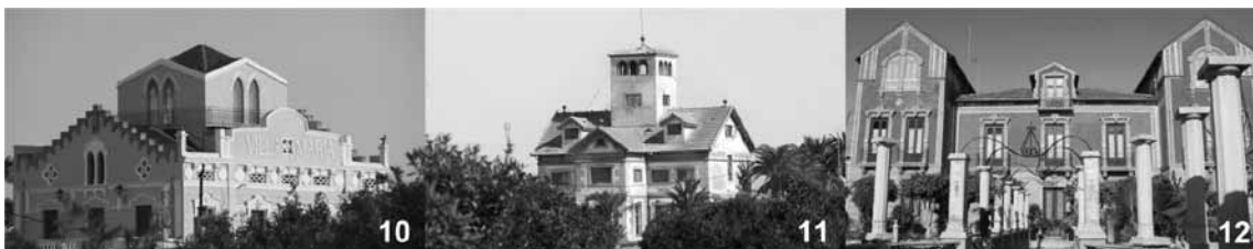
Figura 10. Villa María (La Piqueta). Figura 11. Villa Carmen (Torre Valeriola). Figura 12. Villa Esperanza (Finca Alcantud)
